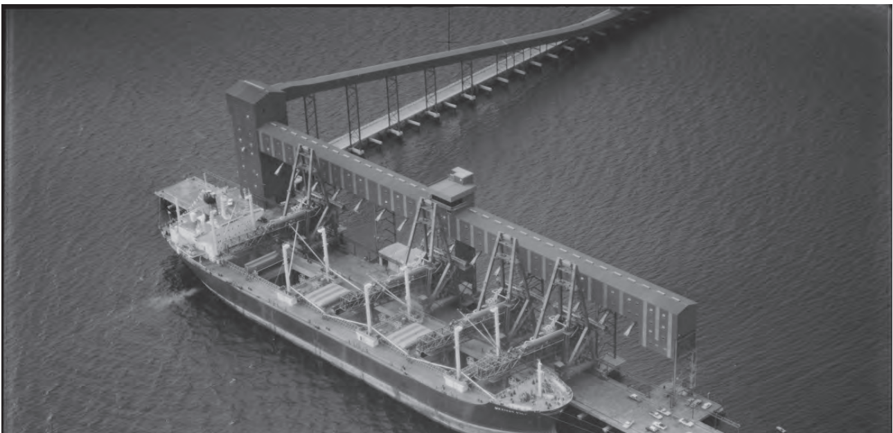
Image 80: Kwinana Grain Terminal Jetty
